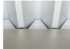
Được lắp giữa mái tôn lạnh và dầm để ngăn các động vật nhỏ xâm nhập.
